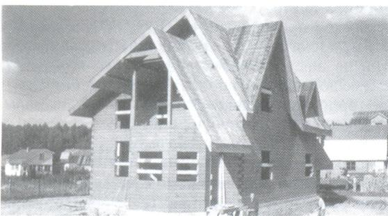
Рис. 2. Проект дома из строганого бруса сечением 150x200 мм общей площадью 270 м<sup>2</sup>
