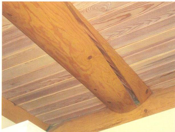
Рис. 2. Трещина в балке перекрытия жилого дома
