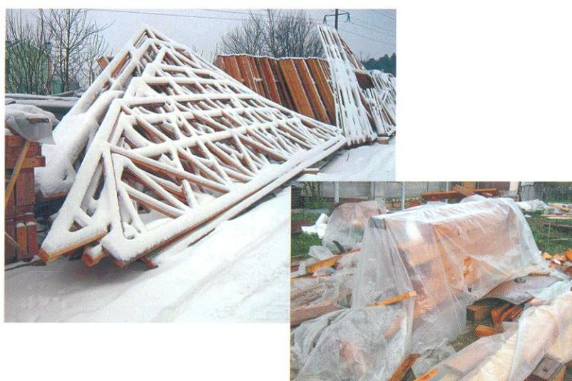
Рис. 5. Недопустимое хранение конструкций: предопределено их неизбежное разрушение
