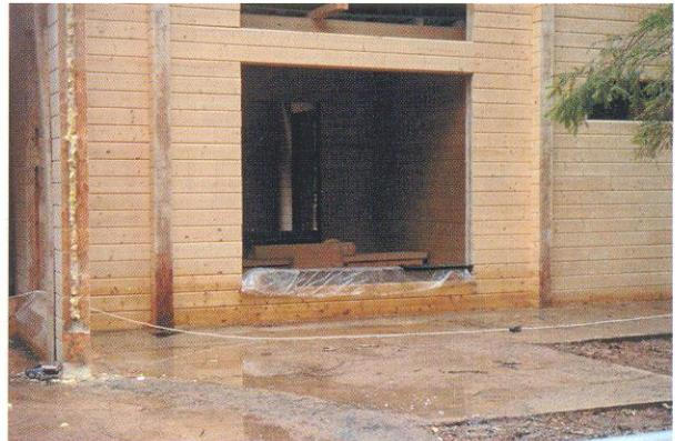
Рис. 3. Отсутствие гидроизоляции между бетонной плитой и древесиной, приводящее к гниению древесины конструкций
