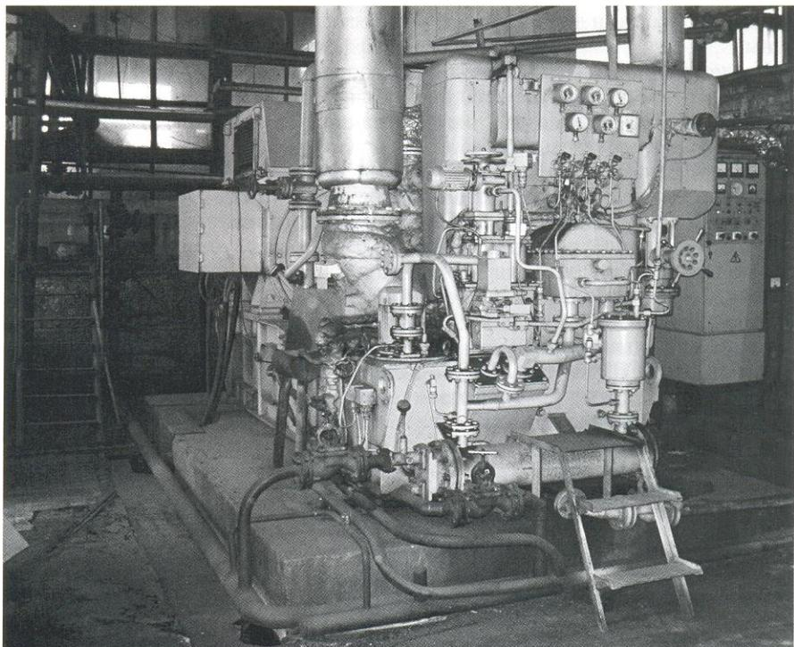
Рис. 1. Паровая турбина мощностью 700 кВт на ТЭС лесопильного завода (Вологодская обл.).
