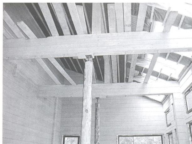
Рис. 1. Несущие конструкции, которые уже на стадии монтажа требуют наличия подпорок
