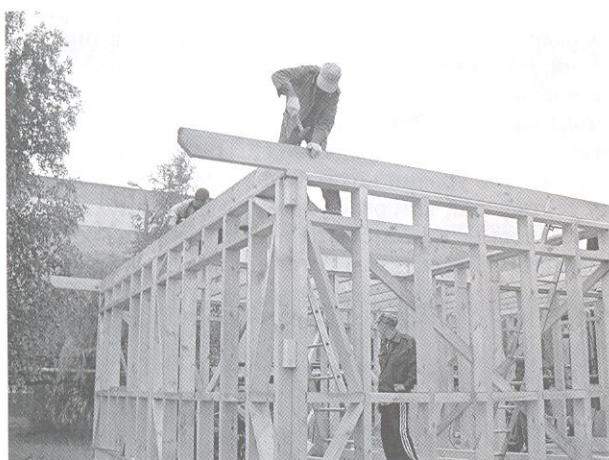
**Рис. 6. Возвведение каркаса стен дома по системе “Макудом”**
