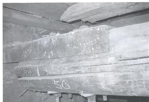
Рис. 4. Дефектный опорный узел
